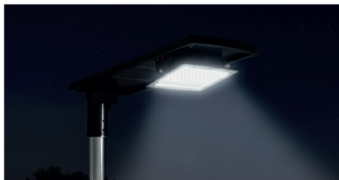
Instalación 2 Montaje con brazo
